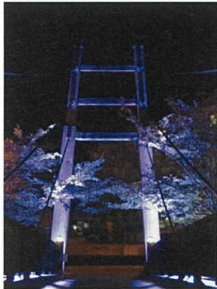
【せせらぎ橋】木造の吊柱をカラーライトアップ、地覆部・路面への間接照明
