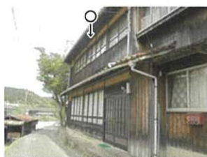
○縦板張りとし、土壁に木組みの外壁
