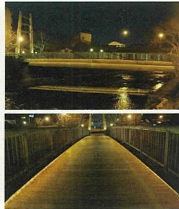
【せせらぎ橋】木造の吊柱をカラーライトアップ、地覆部・路面への間接照明
