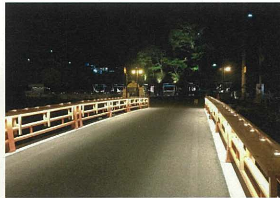
【千代橋】欄干を利用した間接照明を設置し路面の明るさを確保 (写真は2017社会実験の様子)
