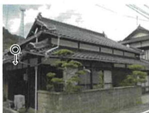
○下見板張りとし、漆喰に木組みの外壁
