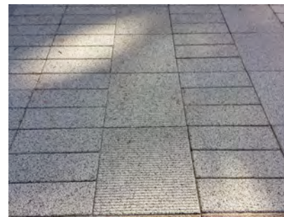
半たわみ性舗装：バス回転スペース 擬石インターロッキングブロック・平板舗装：駐車場歩道・広場
