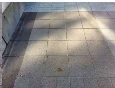
半たわみ性舗装：バス回転スペース 擬石インターロッキングブロック・平板舗装：駐車場歩道・広場
