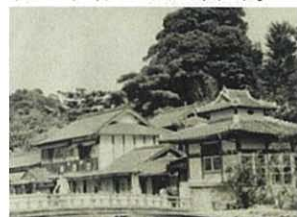
かつての小松館の外壁も板張りとし、真壁木組み現し
