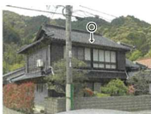
○アルミサッシで連続窓を実現した例
