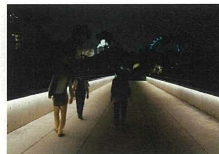
手すり照明のみで通路階段を照射した事例
