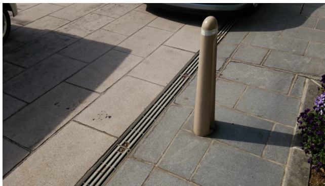
存在を主張しない細幅のスリット側溝蓋の使用を推奨 縁部はコンクリートが舗装表層に現れないようにする
