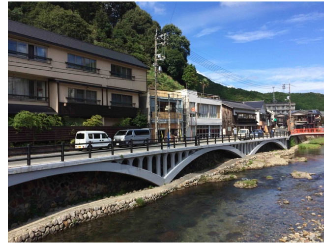
張り出し道路を支えるアーチ構造材の現状
