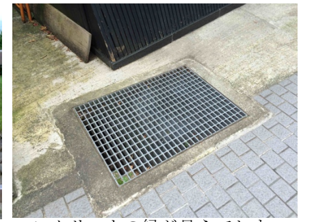
コンクリートの縁が見えてしまっている排水施設の事例
