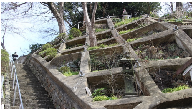
法面内枠植生工により緑の季節にはコンクリート枠の存在感が軽減される。
