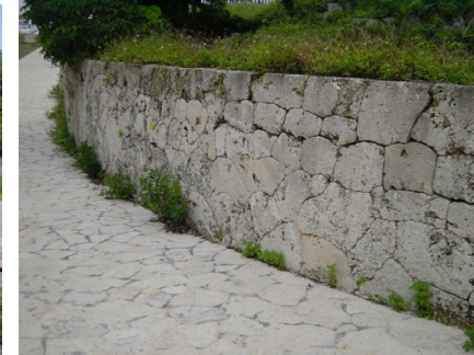
石灰岩を使用した舗装と擁壁 （沖縄県那覇市・那覇新都心）
