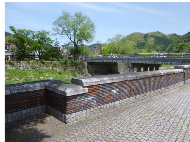
自然石と地域の特産品である瓦を護岸のパラペットに用いて構造物の洗練度を高めている。 (島根県津和野町・津和野川護岸)
