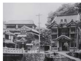
昭和初期の恩湯と枕水の外壁は板張り。軒下部分は真壁木組み現し
