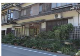
○1階開口部に木製格子を設置し防犯性を高める
