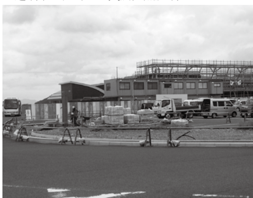
▼建設中の仙崎地区交流拠点施設
