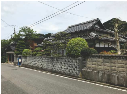
門前の黒瓦・入母屋の建物例
