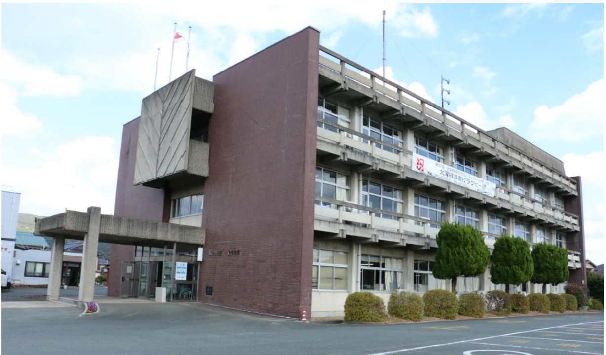
建設から50年以上が経過した油谷支所
