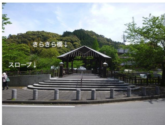
C2: きらきら橋 (音信川左岸側) ・屋根がかけられベンチがある歩行者専用橋である。
