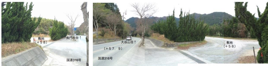
1a : 国道 3 1 6 号側から敷地入口をみる (左右とも)
