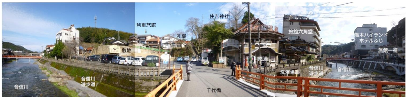
6a：千代橋から敷地をみる（温泉街の最も重要なアングルのひとつ）
