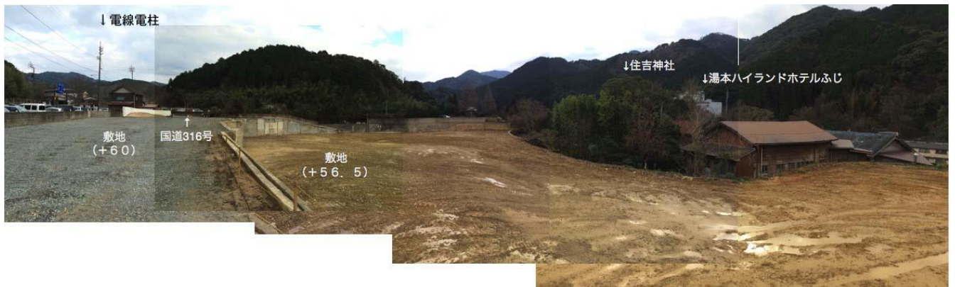
4d：標高60m宅盤西側から標高56.5m宅盤をみる
