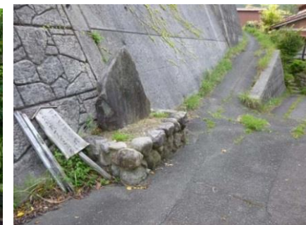
お地蔵様のこみちにある誘導サイン ・木製サインが倒れている。
