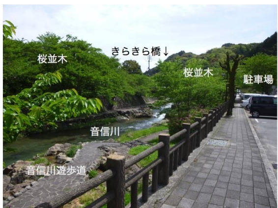
C5: きらきら橋左岸下流 ・道路と遊歩道のレベル差が小さい。擬木転落防止柵の存在感がある。 ・道路幅員が広い区間は駐車場となっている。
