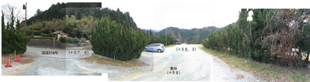
1c : 敷地入口付近から南方向をみる
