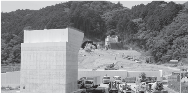
▲工事が進む大寧寺第3トンネル
