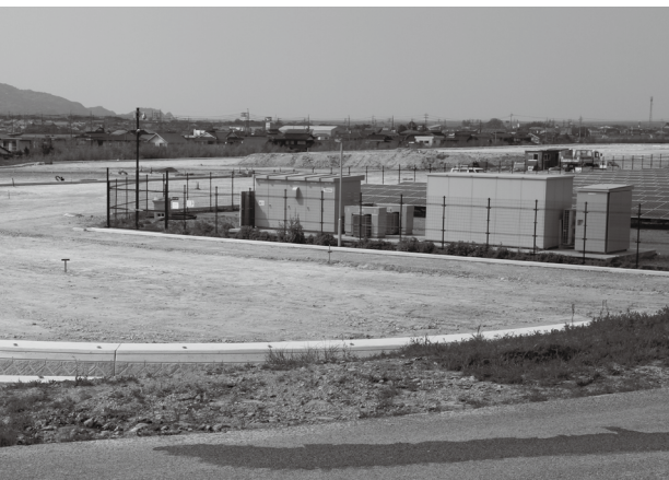
建設中のながとスポーツ公園
