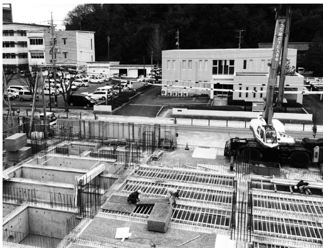
建設工事が進む消防庁舎
