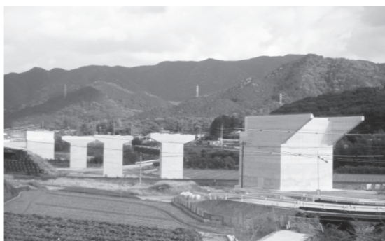
▲工事が進む長門・俵山道路（深川湯本）
