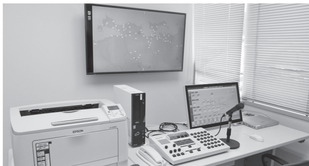
▲庁舎内に整備された防災無線施設
