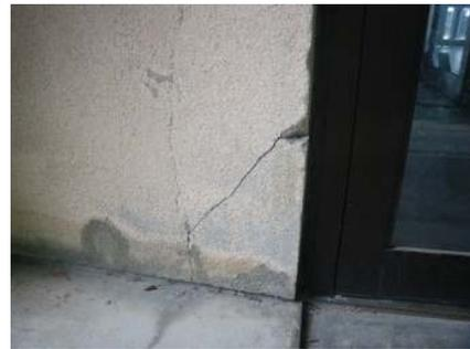
庁舎北側入口の壁の亀裂
