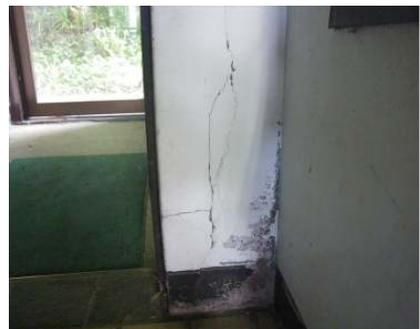
庁舎北側出口の壁の亀裂状況
