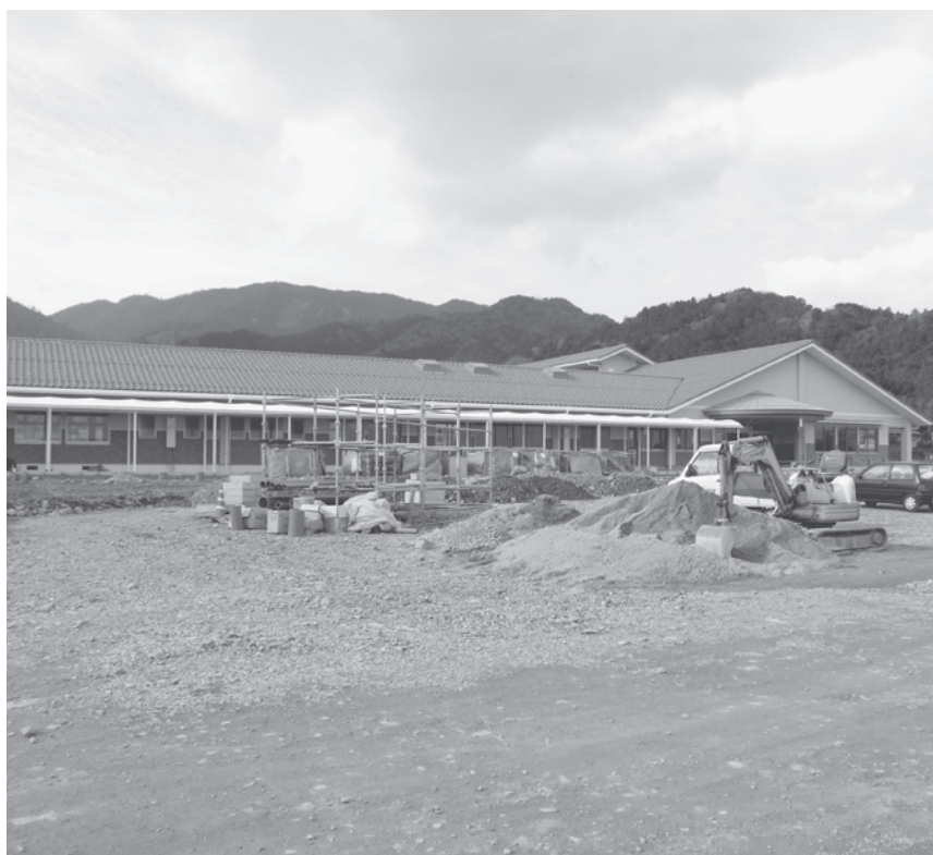
建設の進む新保育園
