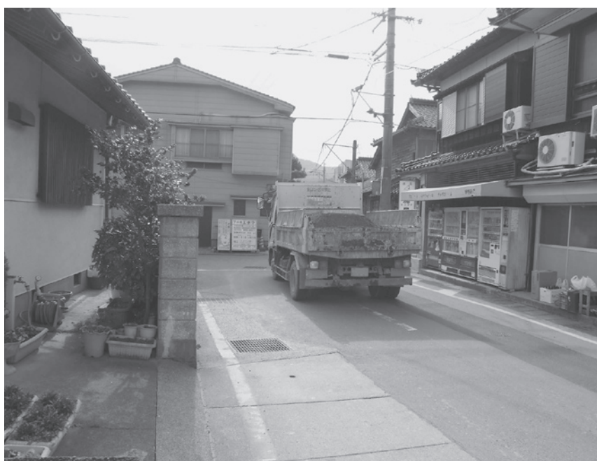
トラブルのあった工事場所周辺（油谷地区）
