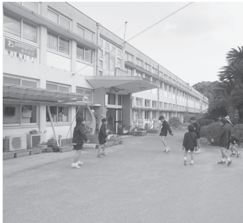
老朽化の進む深川小学校
