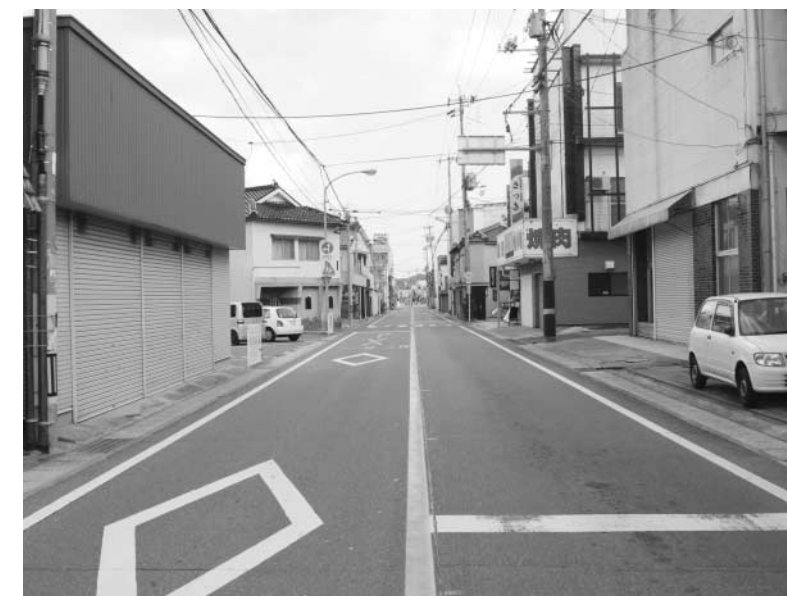
半路肩で1.75mの歩行者空間を確保 (湊中央2号線)
