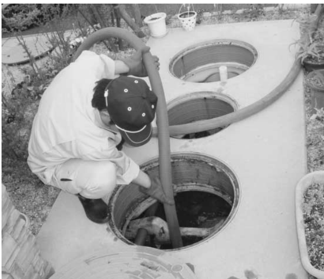
合併処理浄化槽の清掃中の風景
