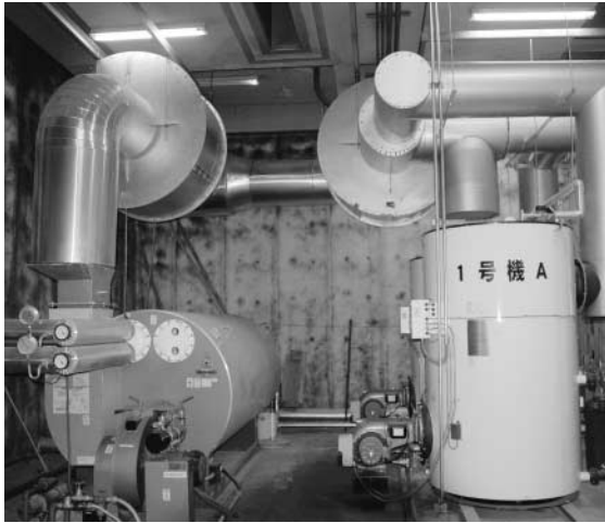
湯本温泉集中加熱センターのボイラー室
