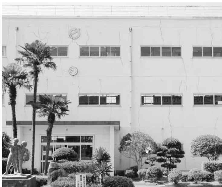
耐震性が気になる油谷小学校
