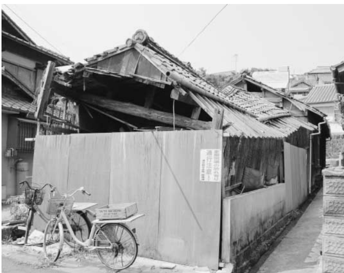
倒壊の危険のある廃屋
