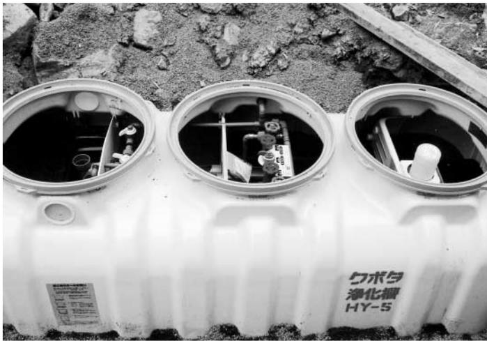
設置工事中の合併処理浄化槽
