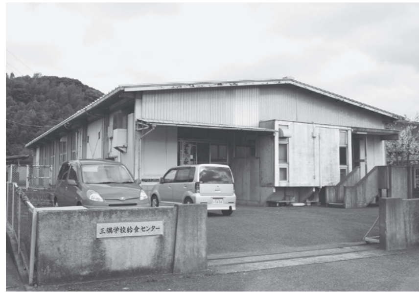
老朽化がすすむ給食センター
