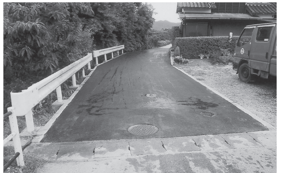
小規模道路改良等助成事業を利用し舗装した道路
