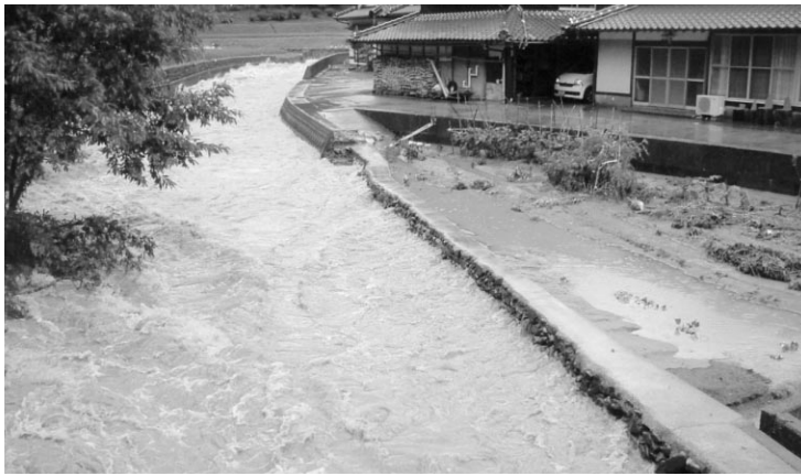
豪雨による河川の氾濫（三隅地区）
