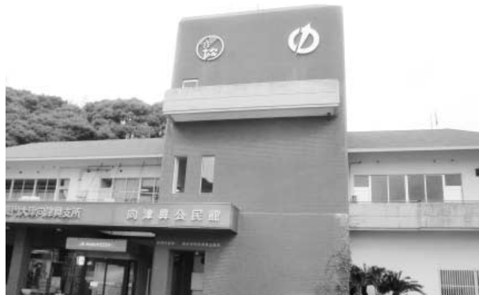
バリアフリー化が急がれる公共施設（向津具公民館）
