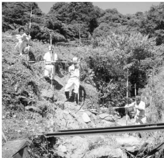
豪雨による災害復旧事業（日置地区）
