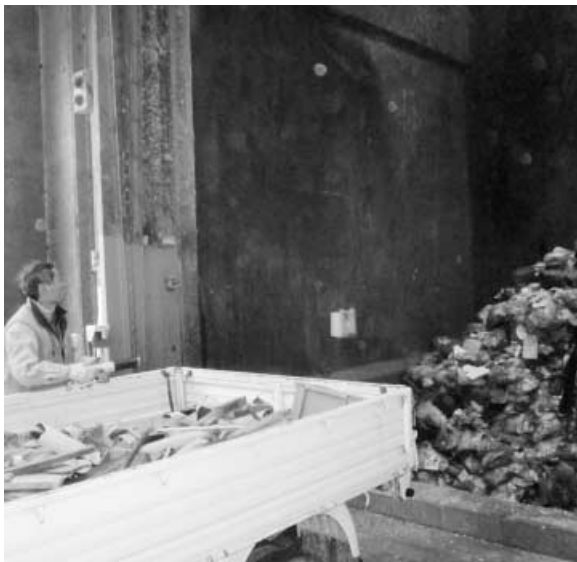
ごみ減量化等が急がれる現焼却施設
