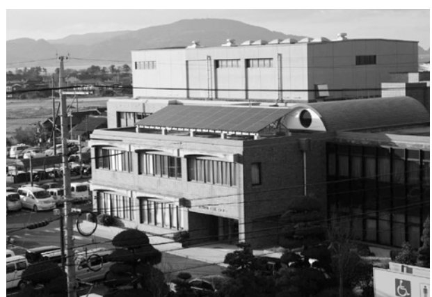
物産観光センター屋上にある太陽光パネル
