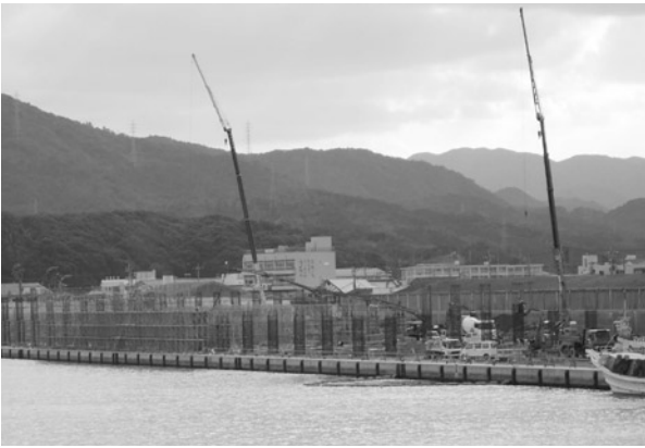
現在建設中の仙崎新市場
