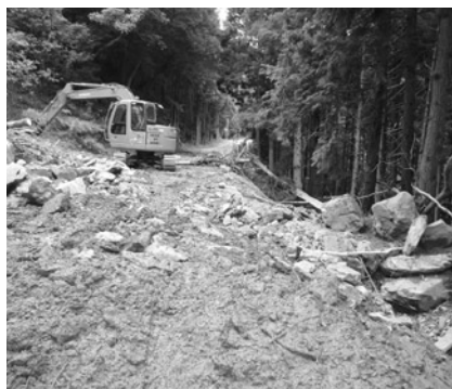
生活道を寸断した土砂災害 (平成 21 年 7 月)
