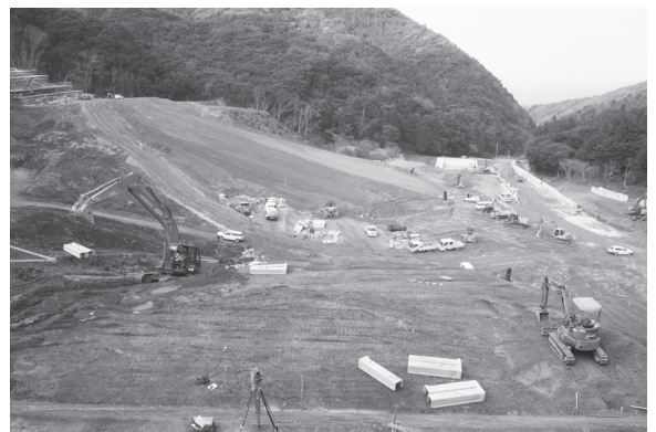
▲造成が進む新ごみ焼却施設建設予定地（萩市）
