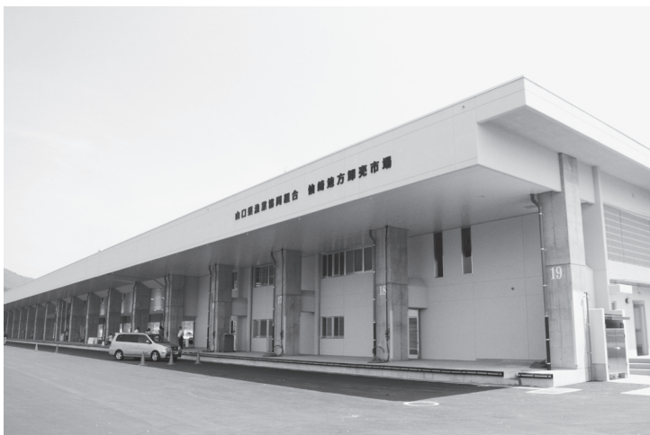
▲平成 24 年 7 月に完成した仙崎新市場
