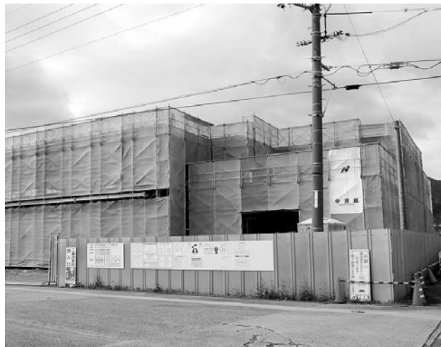
▲建築が進む給食センター(3月上旬撮影)
