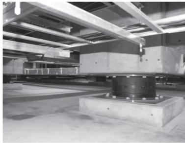
▲免震構造を採用し、最高水準の耐震性能を確保。災害から庁舎を守る
