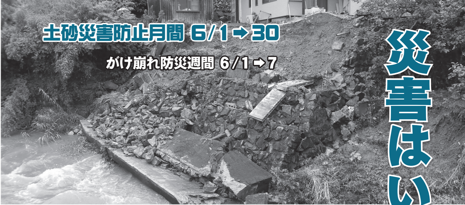
▲平成 26 年 7 月に発生した増水によるがけ崩れ (西深川地区)
