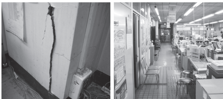
▲現本庁舎の壁には亀裂も見られる ▲現本庁舎1階の狭くなった通路
