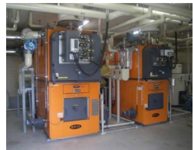
■大型チップボイラー
