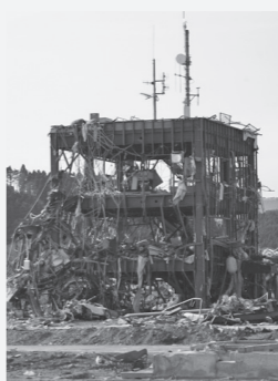
▲被災した防災対策庁舎
